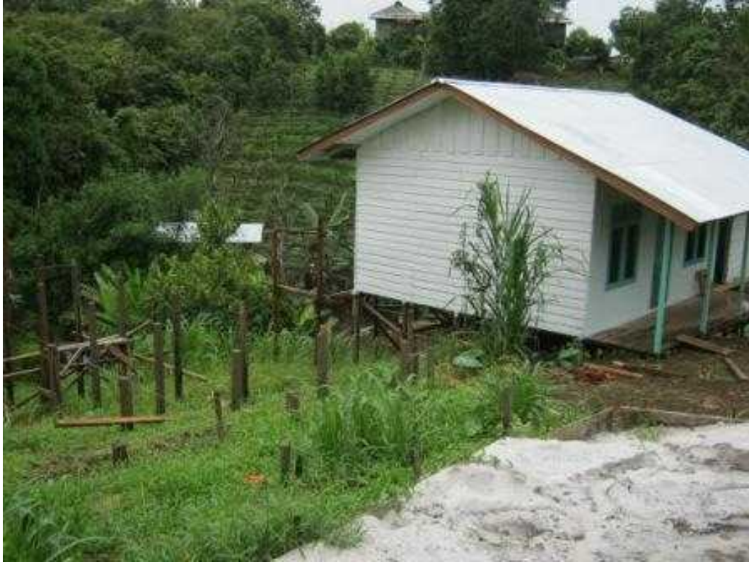
Salah satu rumah Ustadz yang selesai dibangun dan pondasi rumah selanjutnya
