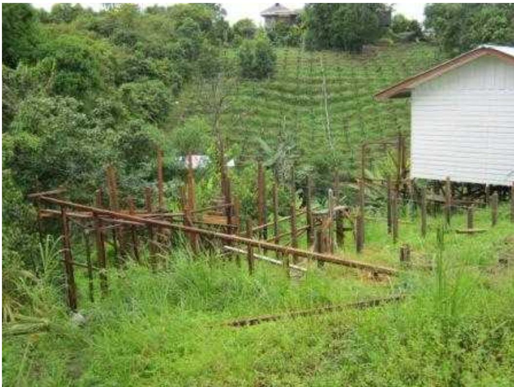
Pondasi untuk pembangunan rumah Ustadz berikutnya
